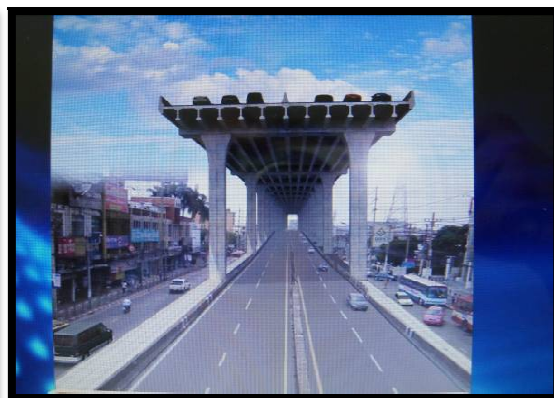
รูปตัดยกระดบโครงสร้าง ยกระดบ 28 เมตร ช่วงผ่านมหาวิทยาลัย โครงสร้างยกระดบคล้ายอุโมงค์ช่วงทางผ่านงามวงศ์วาน-เกษตร
